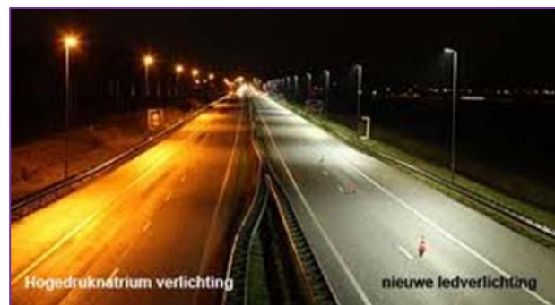
Foto 9 Hogedruknatrium verlichting versus ledverlichting
